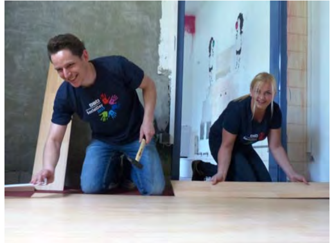
Boden verlegen im Hausaufgaben-Übungsraum
